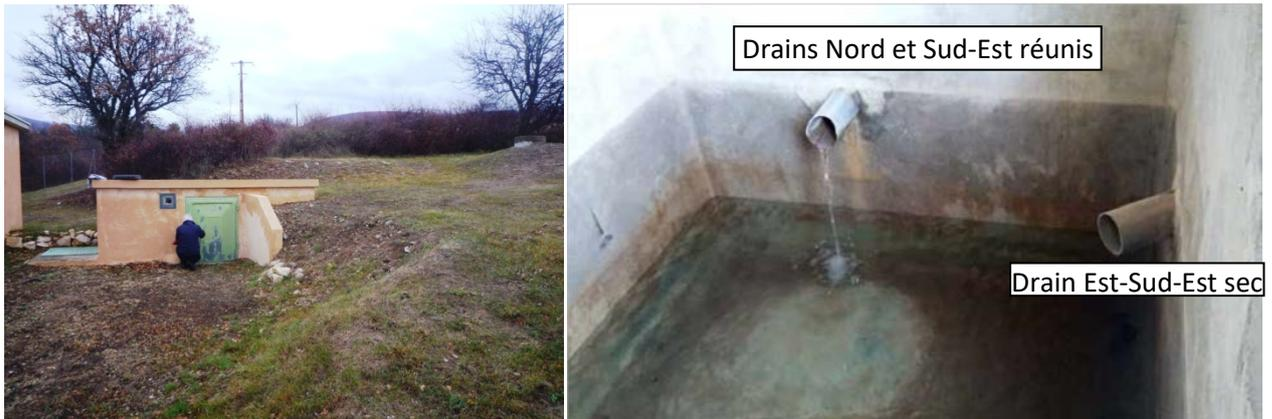
Figure n°4 : La bâche de collecte (7m<sup>3</sup>) et les arrivées des drains (drain Est-Sud-Est sec)
